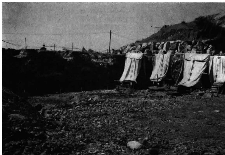
図 8 建築工事現場全景（1972. 10.12） （図5のスケッチとほぼ同じ角度からの写真）
