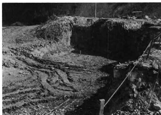
図 6 建築工事現場 (1972. 10.12)
