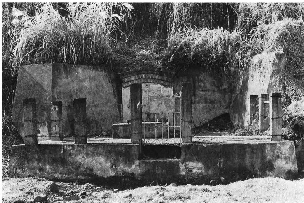
写真2 紀伊の守第3, 第4水源（隧道入口）
