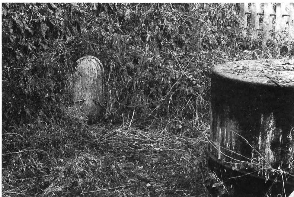
写真1 紀伊の守第1, 第2水源（隧道入口と結合井）
