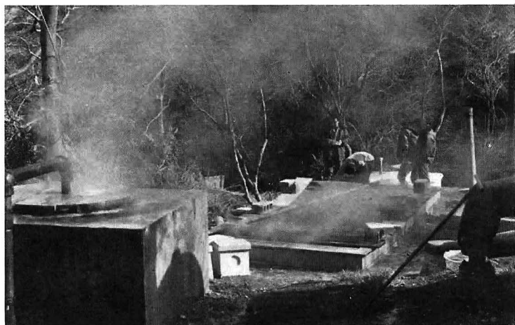
写真1 湯ノ花沢（箱根町）の 造成槽と湯畑
