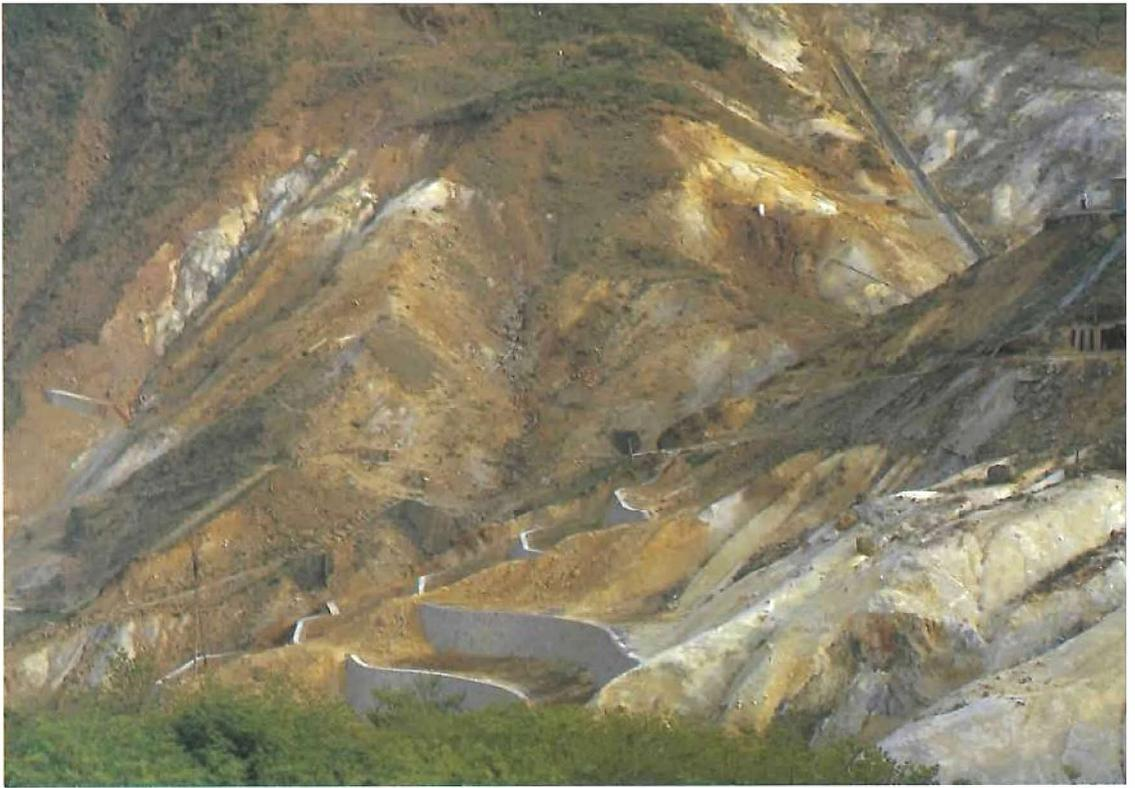
写真 5 大涌谷中央部の山腹土止工事
