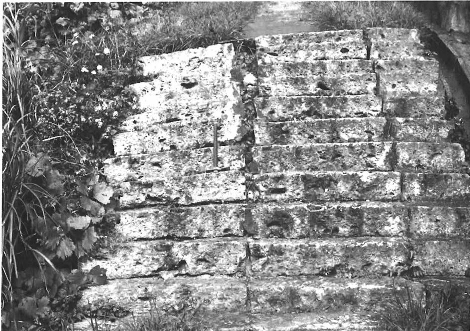
写真2 崖の側に引きずられた階段（同上）
