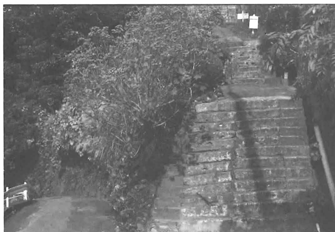
写真 4 斜面崩壊前 昭和61年12月 6 日
