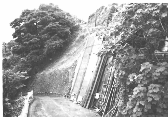
写真 6 斜面安定工事 昭和62年 8 月
