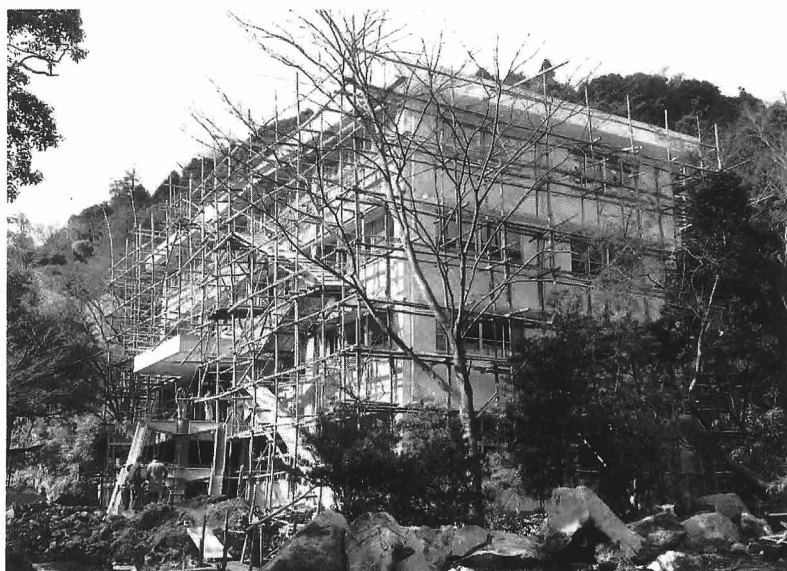
写真1・7 新庁舎（箱根）建設
