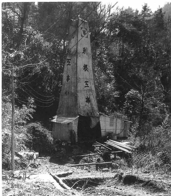
写真2・1・11 久野観測井 深度300m掘さく工事(1972年) 箱根火山の基盤岩温泉の調査孔
