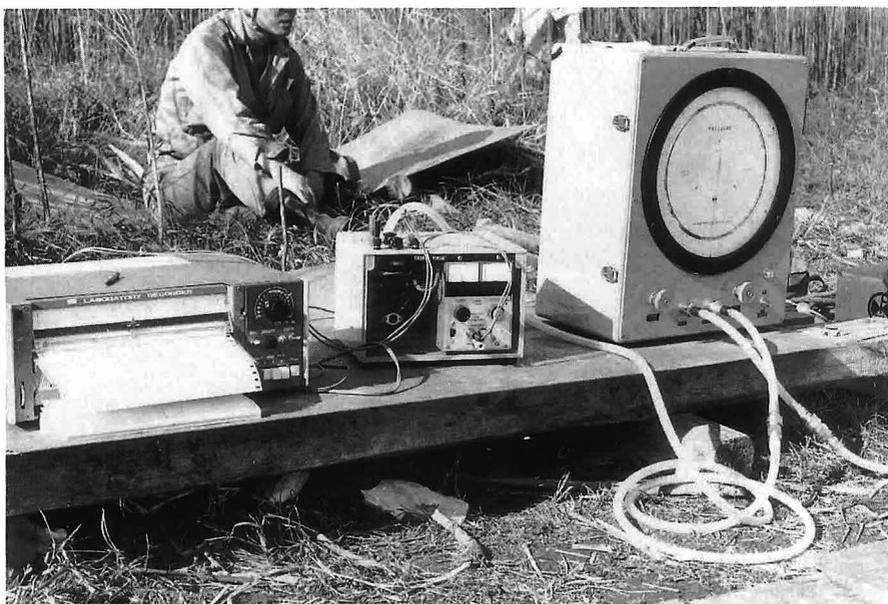
写真 2・1・33 揚湯試験による圧力（水圧）変化測定（1972年）、圧力計と記録計
