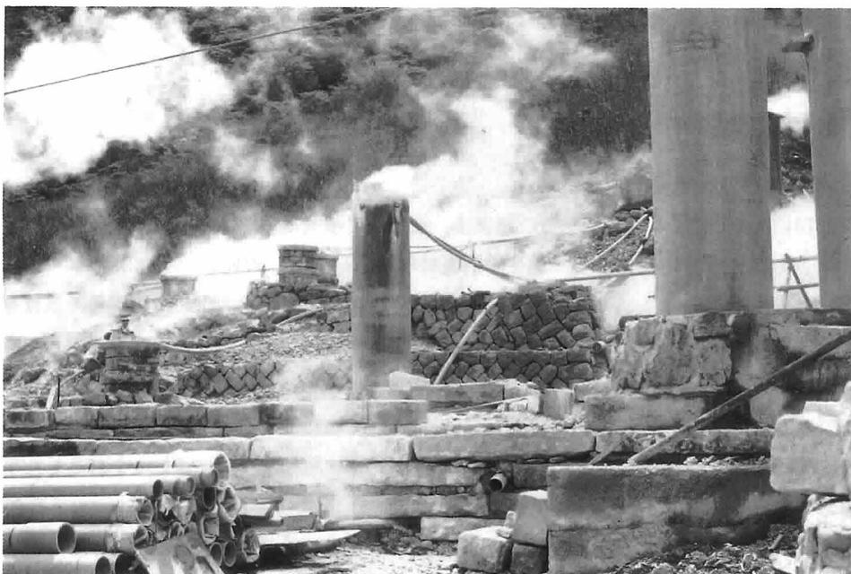
写真 2・1・20 箱根大涌谷噴気地帯と温泉造成塔（火山性蒸気と地下水などの混合装置）
