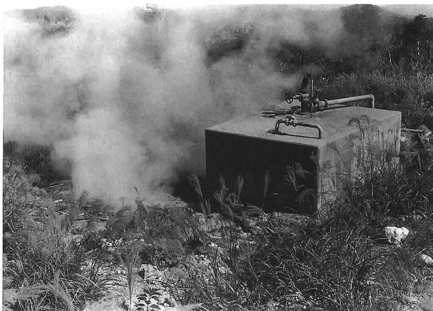
写真2・1・23 箱根湯の花沢、蒸気井の蒸気漏れで周辺噴気地化し、自然環境破壊（1980年）
