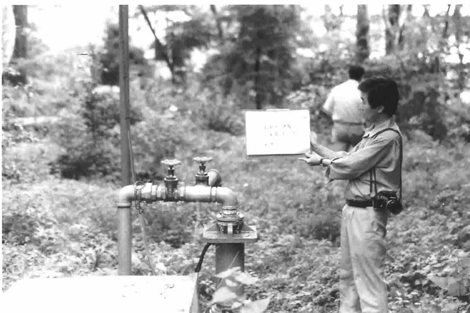
写真 2・1・28 箱根強羅の水井戸調査 (1983年 8月)、深度90mの揚水井 (280 ℓ/min)
