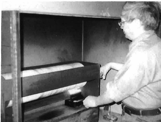
(b)ドラムを回転させながら記録紙に煤をつける
