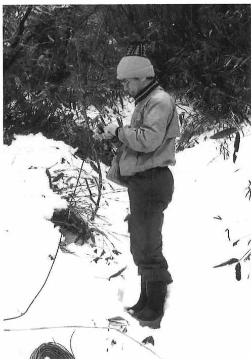
(b)電線の修理（1986年3月）
