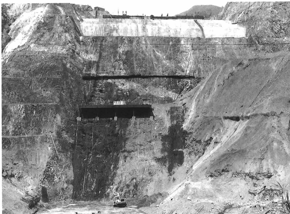
写真 2・4・1 三保ダム工事中の洪水吐正面（1976年）
