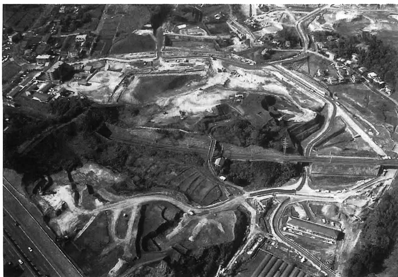
写真2 宅地造成工事中の赤田
