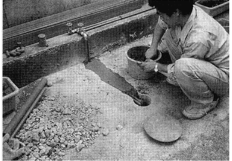
写真2 事業所内ボーリング調査 (調査孔の仕上げ)
