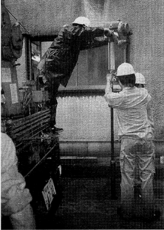
写真1 事業所内ボーリング調査 (調査孔の掘削)
