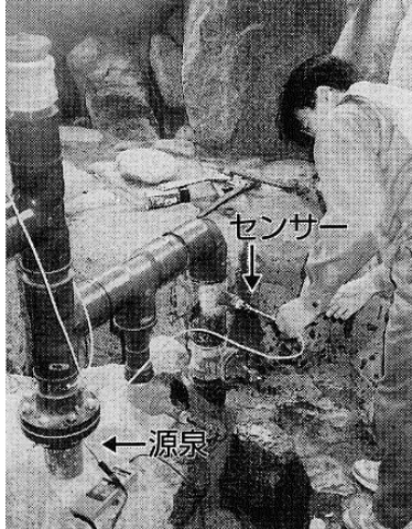
写真 6 中川第 2 号源泉(矢印:センサー取付位置)
