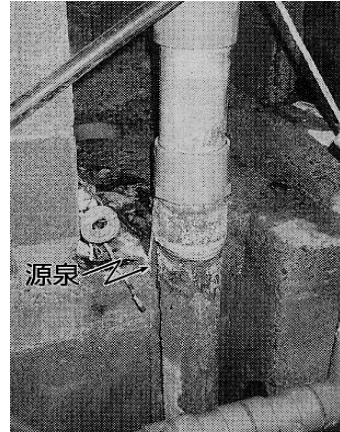
写真 7 中川第 4 号源泉(センサーは鉄管の中)
