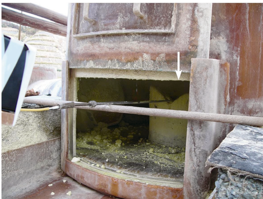
写真6 蒸気井ガス GB の採取。矢印は蒸気井の出口
