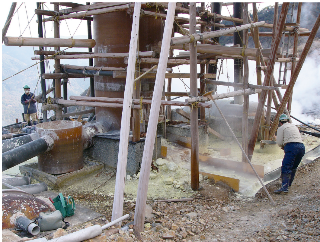
写真5 大涌谷 No. 52 蒸気井の出口に作られた温泉造成施設
