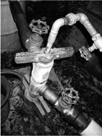
写真7 塔之沢温泉で利用されている源泉。温泉はエアリフトポンプを利用してここから汲み上げられています。
