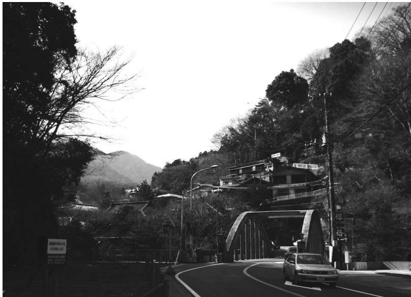
写真5 国道1号線の千歳橋付近。国道を上ると、ここから塔之沢温泉が始まります。
