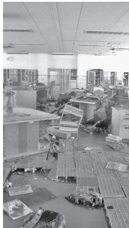
写真6 地震発生時にいた本館1階の職員室（3月12日9時44分）。
