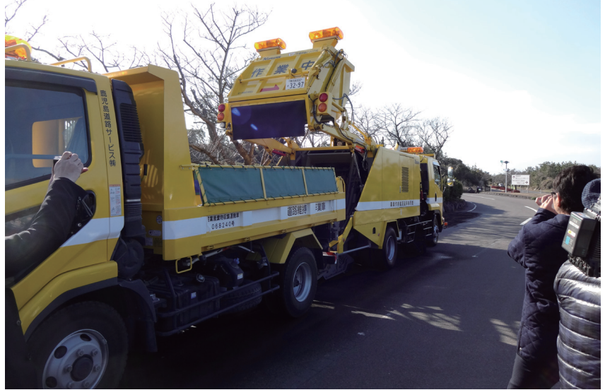
写真5 ロードスウィーパーにたまった灰をトラックへ積み込む様子（2015/01/31撮影）。
