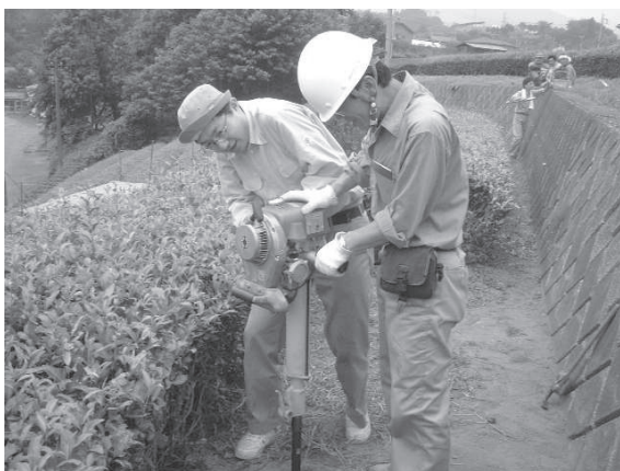
写真3-3-1 地下水調査のボーリング(2001年7月、津久井にて)
