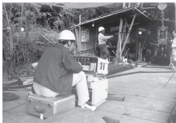
写真3-4-2 電気検層の実施風景(1989年7月)
