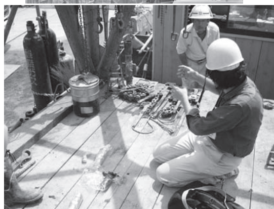
写真 3-1-3、3-1-4 小田原市前川の大深度温泉掘削現場 (2006年6月)
