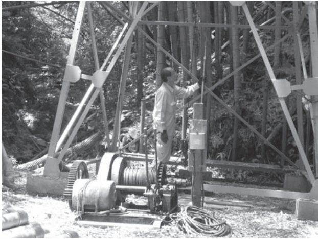
写真3-4-3 電気検層の準備(2012年6月、湯河原にて)
