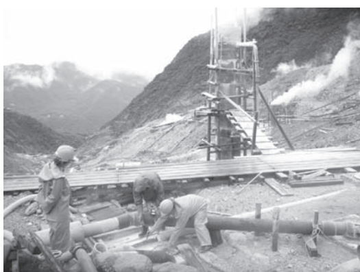
写真 3-1-8 大涌谷造成温泉の調査(2006 年 9 月)
