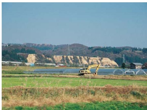
写真5 丘陵と平野の境をなす斜面の崩壊(堀之内町) 地盤が露出している部分は全て崩れている
