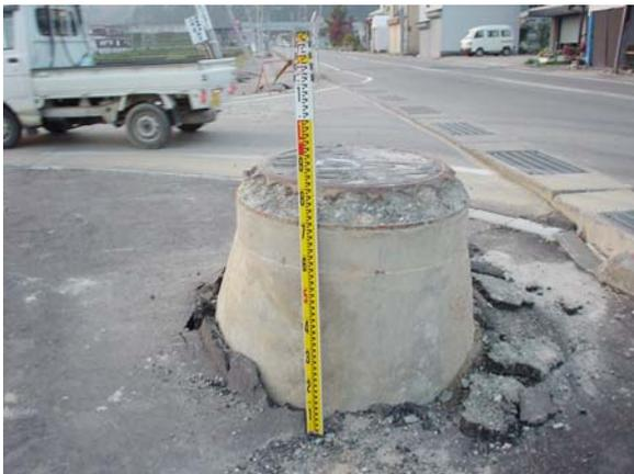
写真2 地盤液状化により抜け上がったマンホール(小千谷市)
