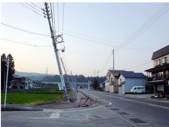
写真3 地盤液状化により傾いた電柱(小千谷市)
