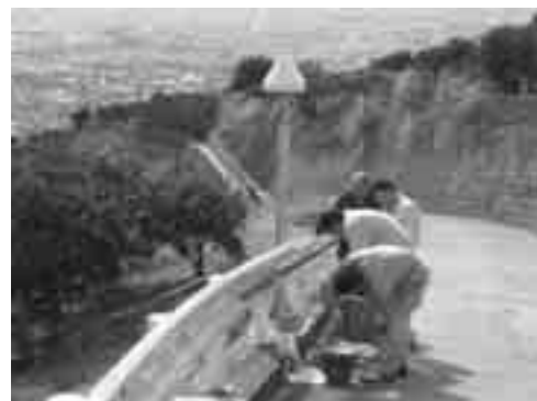
図 6.1-2 GPS アンテナ設置
