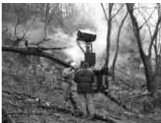
図 6.1-3 火山ガス・地温観測施設設置
