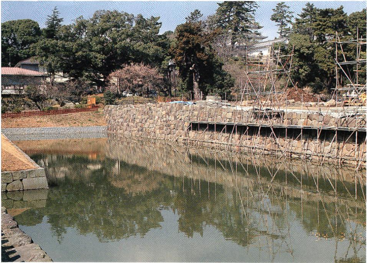
写真 14 水が満たされた中掘（平成 6 年 3 月撮影）
