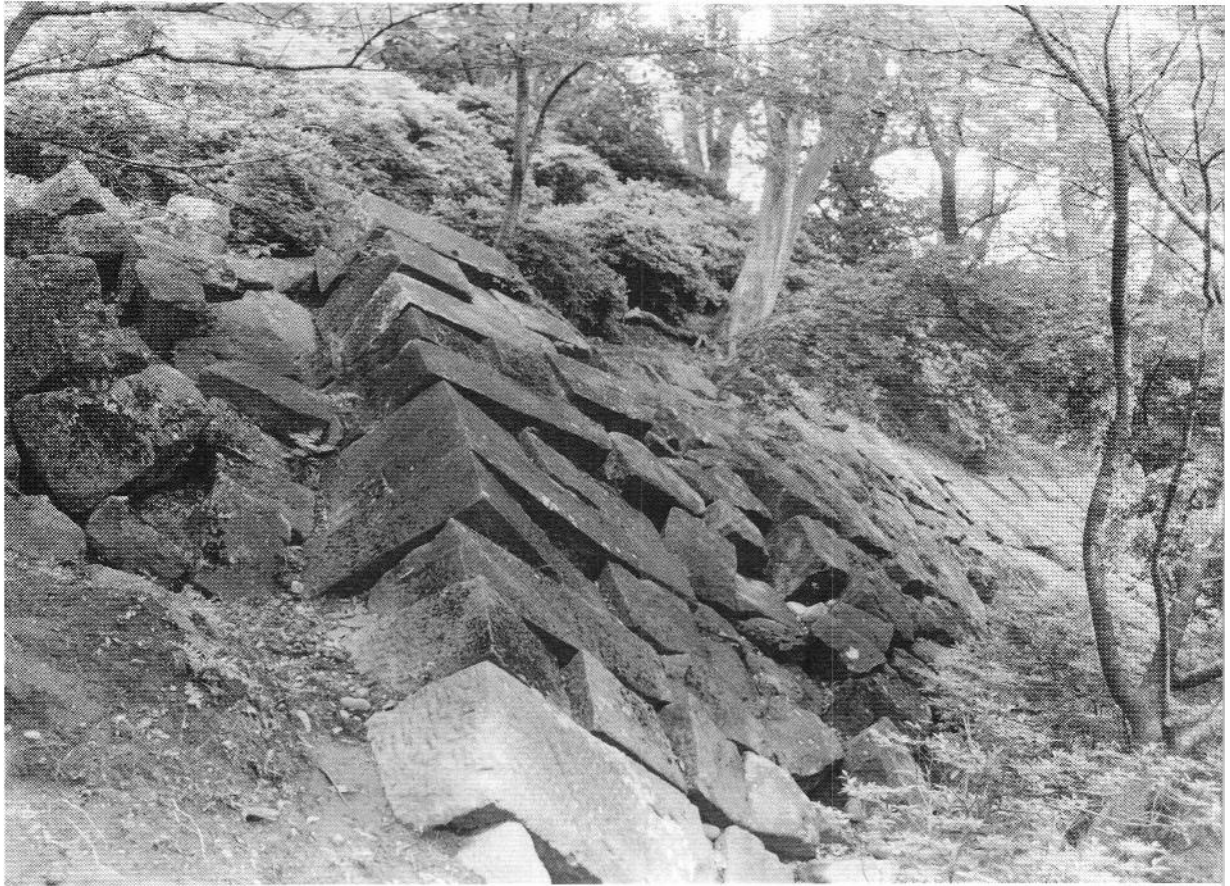
写真6 大正12年の関東大地震で崩れた本丸の石垣
