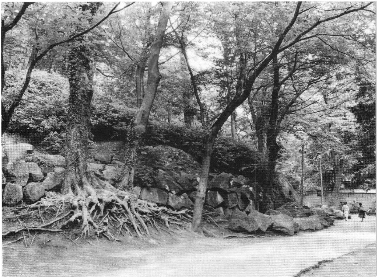
写真7 大正12年の関東大地震で崩れた本丸の石垣
