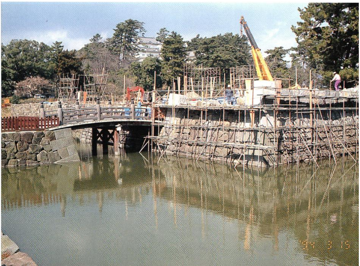
写真 15 復元工事が始まった銅門（あかがねもん）（平成 6 年 3 月撮影）
