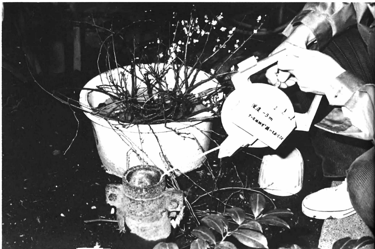
写真7 湯本温泉 昭和40年に自噴を停止したボーリング孔井（湯本第13号泉）は水位変化を追跡する観測井となっています（昭和56年撮影）。この井戸の水位観測結果等は図3、41にあります。
