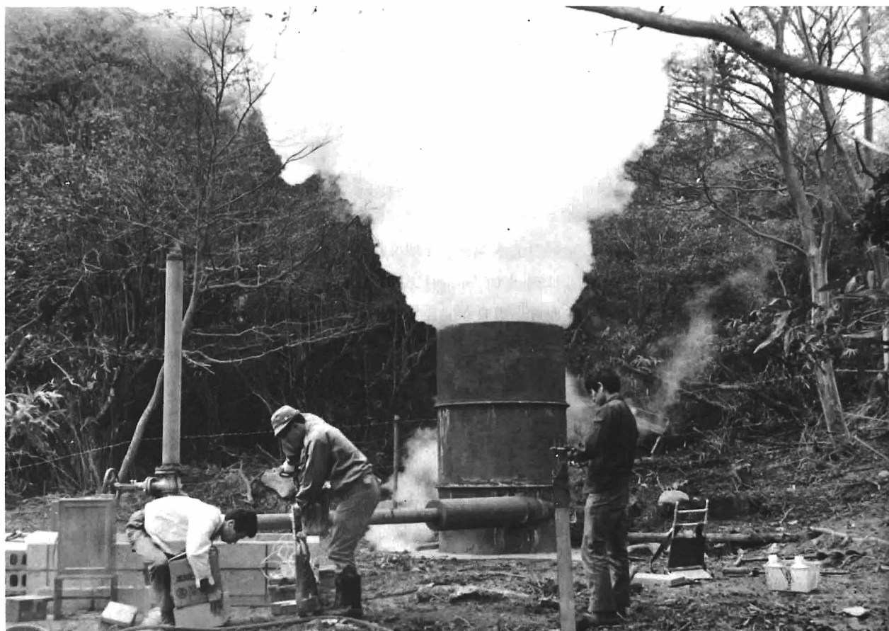
写真14 湯ノ花沢町営蒸気井の蒸気量調査 (昭和46年撮影)
