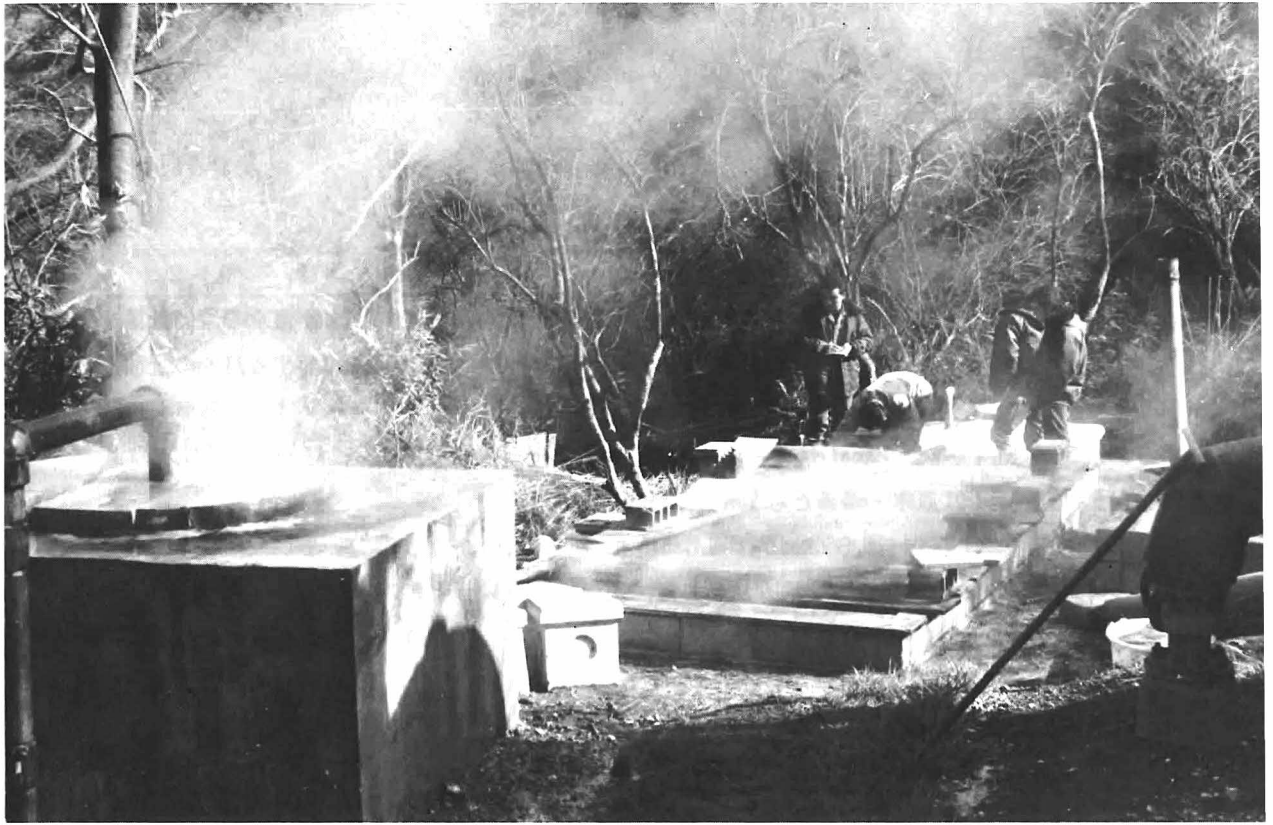
写真15 温泉造成槽（元箱根27号一湯ノ花沢町営蒸気井，昭和48年2月撮影）
