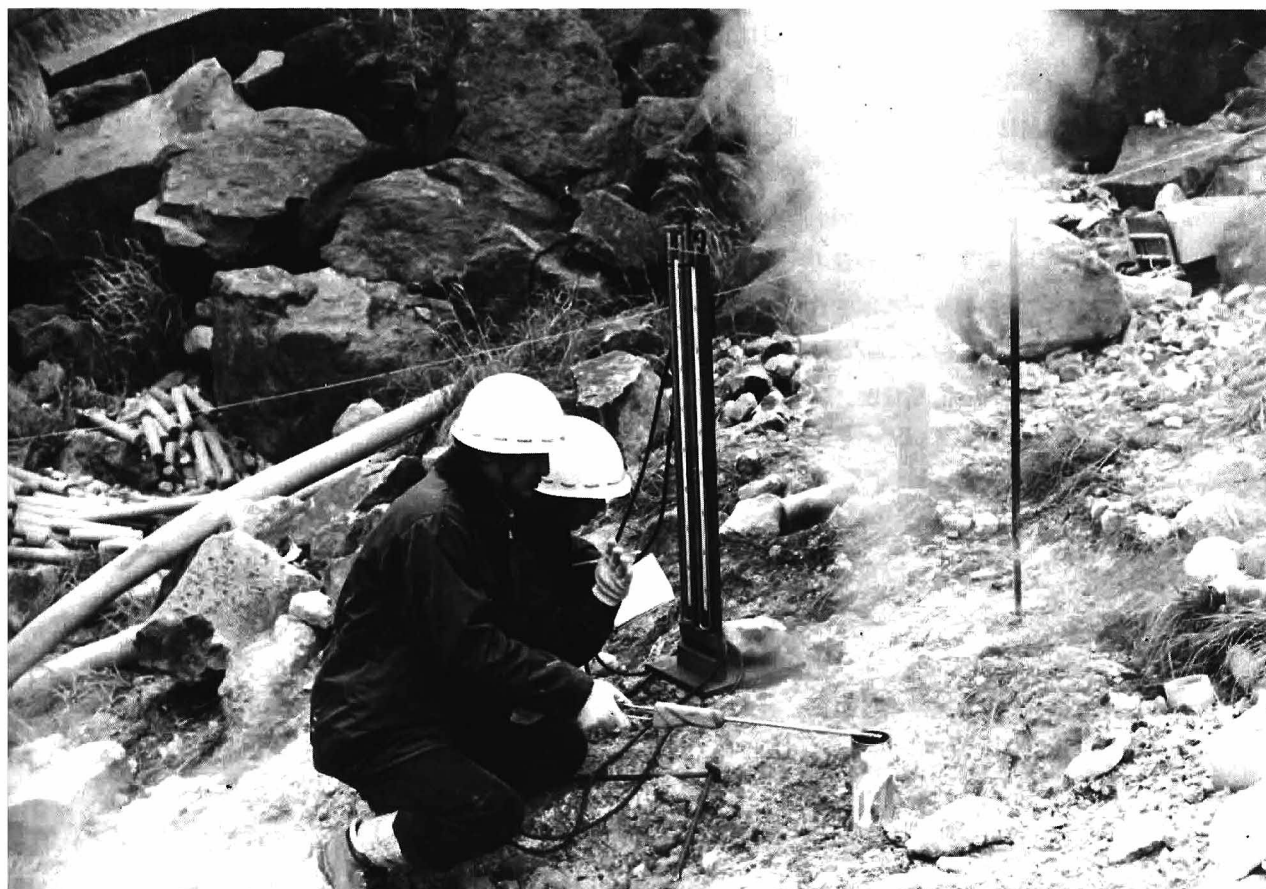
写真13 火山性水蒸気の放熱量測定（早雲地獄にて昭和55年10月撮影）
