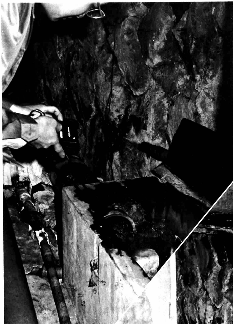
◀ 第3号泉の湧出量を調べる横穴 入口の中継槽
