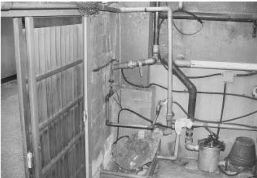
写真3 源泉の揚湯装置(KW28)
