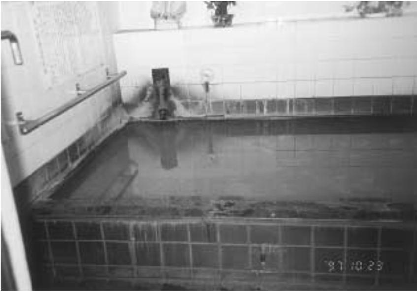
写真1 浴槽に酸化鉄の薄膜が
