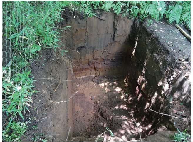
写真2 観測坑設置用に掘られた穴（深さ約2m）
