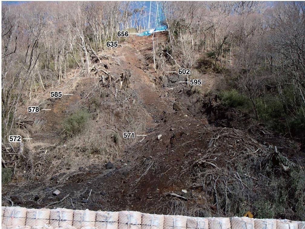
図2 露頭の全景（2020年3月5日撮影）。崩壊の上端に送電線の鉄塔とその足下付近を覆うブルーシートが見える。数字は距離計（Nikon AS500）を用いて簡易的に測量した標高。
