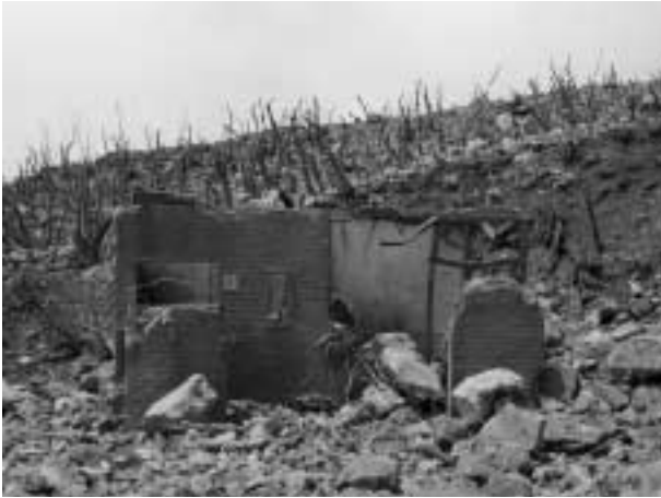
写真7 爆発角礫の空襲によって完全に破壊された山頂駐車場のトイレ。この時、この地点から火口壁までの距離は数十m以下であった。なお、このトイレはその後の火口拡大に伴い8月はじめまでに火口内に崩落して消失した。
