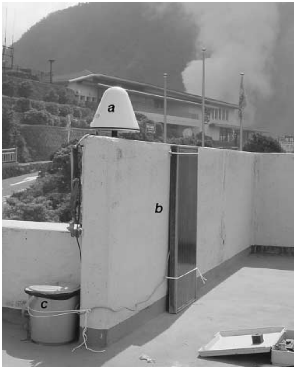
写真1 観測点(OWD点)外観 a: GPS センサーおよびレドーム、 b: 太陽電池パネル、c: バッテリーを収納したバケツ 観測データは、GPS センサー本体内のメモリに記録される。
