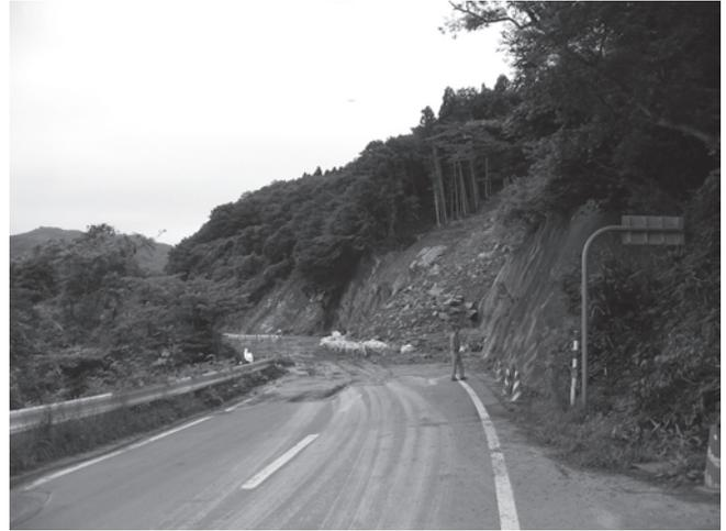
写真4 矢びつダム付近、国道342号の土砂崩れの様子。ここより手前で通行止になっていました。この先には橋桁が崩落した祭時（まつるべ）大橋があります。
