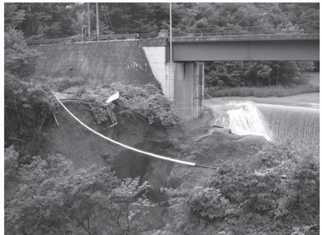
写真6 矢びつダム下流部にかかる昇仙橋の崩落。白く見えるパイプは地震後に新たに架けられた温泉の送湯管です。
