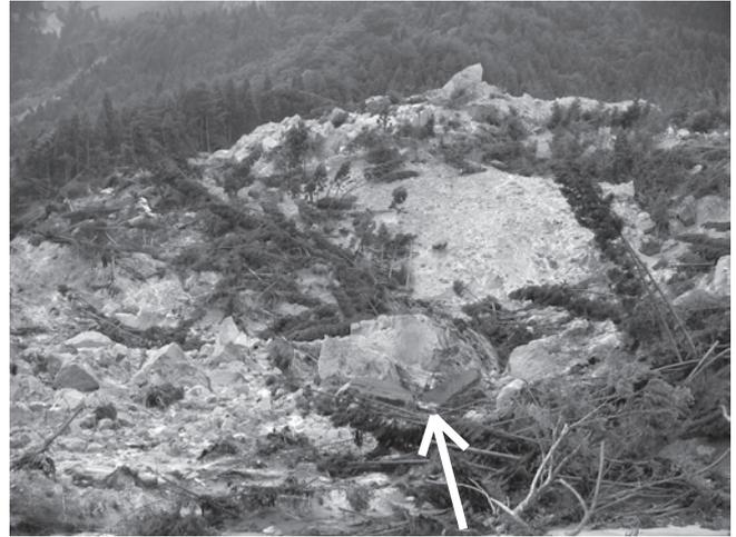
写真 12 写真中央部の、くの字に見える黒い物体（矢印）は、地滑りによって崩壊した道路のアスファルトの残骸です。
