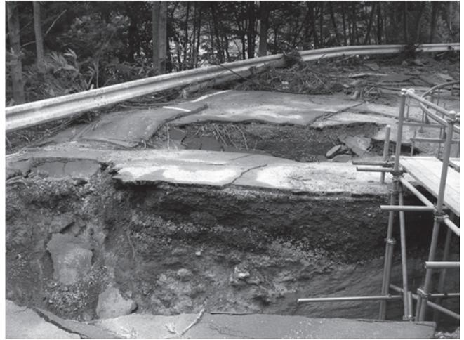
写真10 地割れにより、下の地層がむき出しとなった、ダム湖北岸の道路。これより先の道路は、地滑りによって滑落していました。
