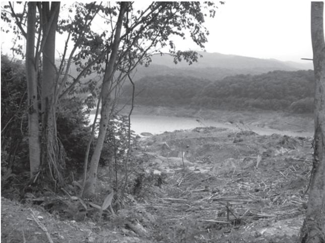
写真9 地滑りによって大量の土砂がダム湖に流れ込んでいます。地元の見撃者によると、ダム湖に3~4mの津波が発生したという話です。
