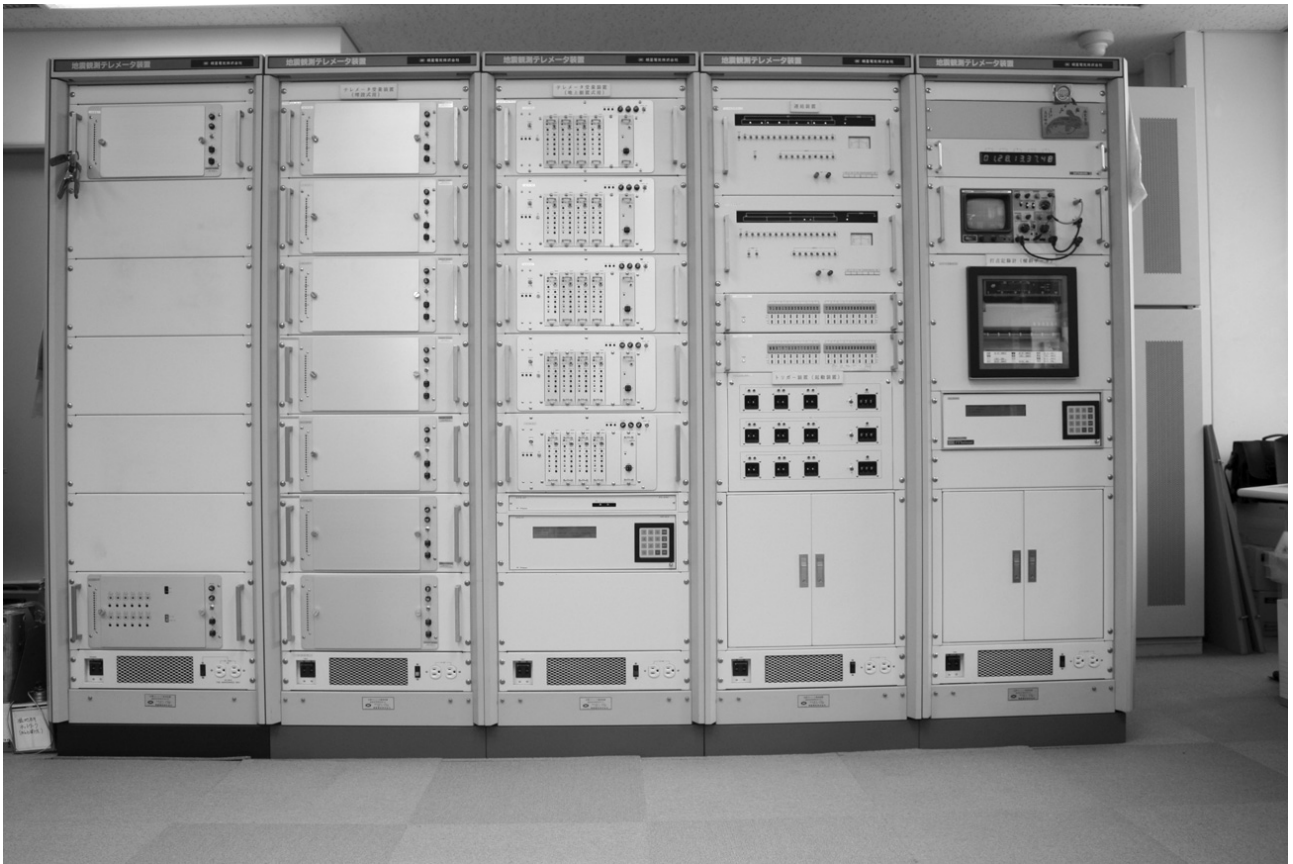
写真1 1989年に導入された、地震データの受量装置
