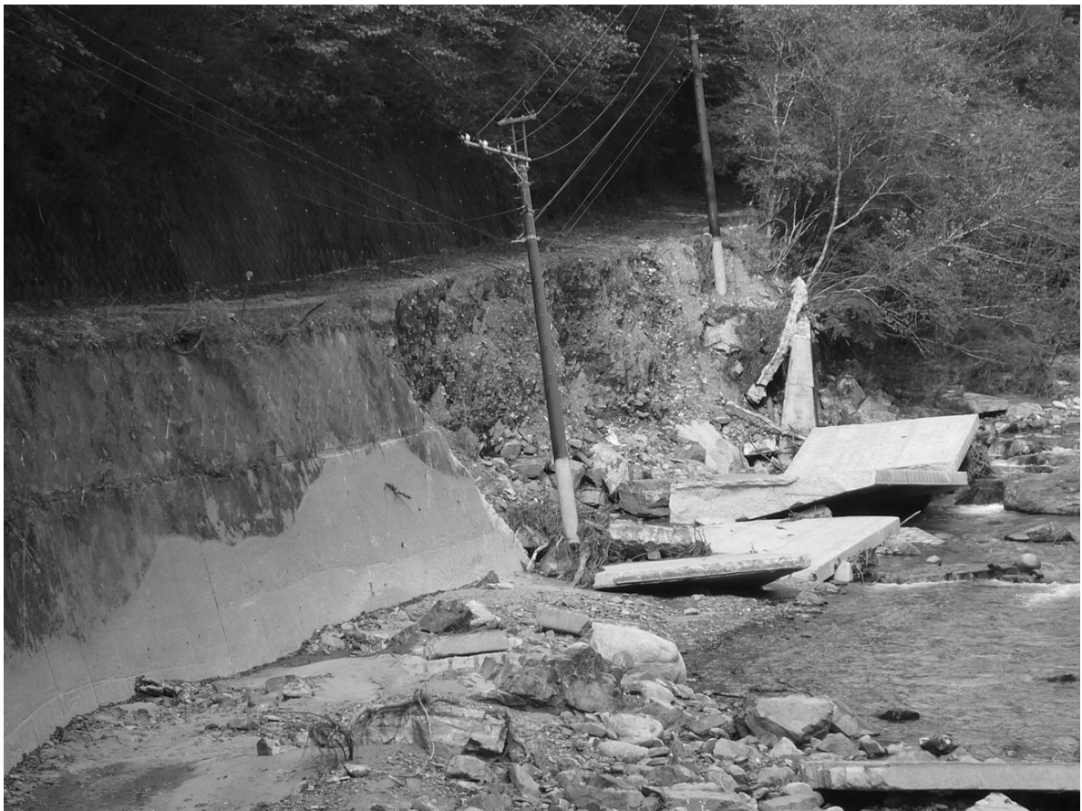
写真2 大又沢観測点に続く林道の崩壊地
