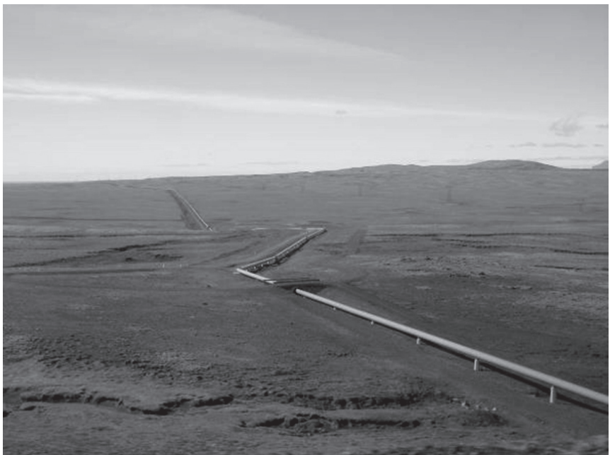
写真3 溶岩台地を通る温水輸送用のパイプライン(環境省, 2011より)
