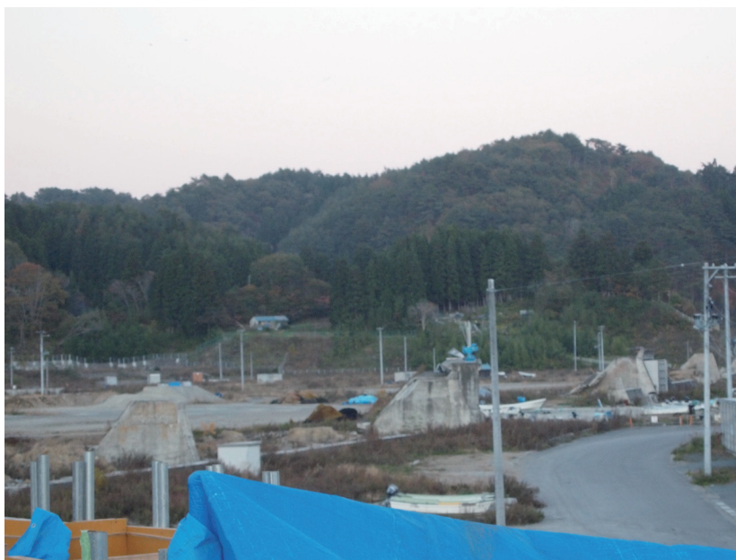
写真 11 津波によって破壊された防潮堤。写真の左手前から右奥に続くコンクリートブロックの並びが、元々の堤防があった場所に相当する。
