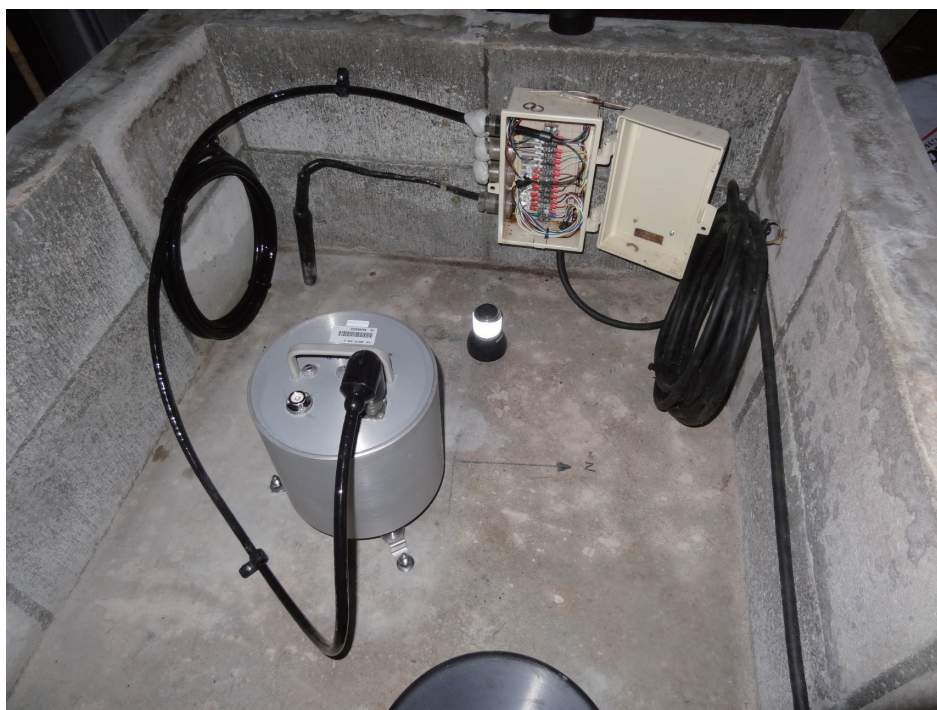
写真 1 更新した地震計 (金時観測点)。
