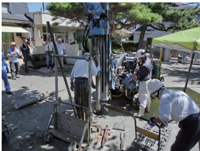
写真 1 津波堆積物調査のための掘削の様子（鎌倉市材木座；2012 年 9 月 9 日撮影）。 クローラー式掘削装置と呼ばれる小型の機械（中央）で、深さ 1 m おきに土砂を採取する。
