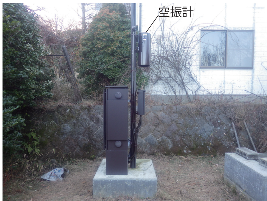
写真 2 下湯場観測点に設置された空振計。
