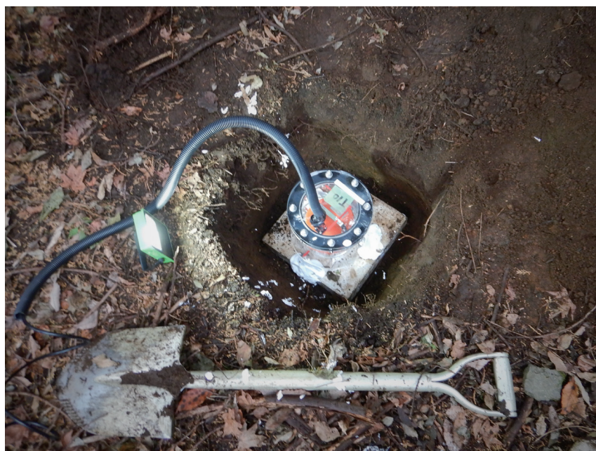
写真2 地震計の設置例
