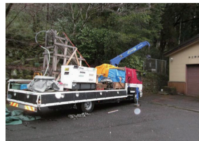
写真3 作業風景。ユニックの荷台に乗っている木製の台座に、新しい地震・傾斜計が仮置きされています。
