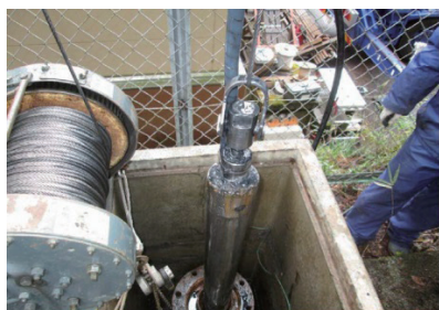
写真 4 既設の地震・傾斜計の引き上げ。ワイヤーを巻いて引き揚げます。
