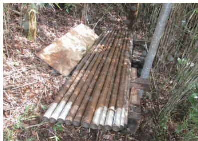
写真 5 地震・傾斜計を埋設するときに使用するロッド。これをつなぎながら、自重を利用して徐々に沈めていきます。
