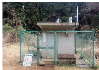
写真 8 裾野観測点。小屋の手前にあるコンクリート製の箱が、地震・傾斜計が埋設された観測井戸です。小屋の中に、テレメータ装置や強震計、気圧計が設置されています。
