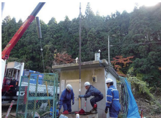
写真10 ダミーの通り試験。作業員の方が手を添えているのが地震・傾斜計のダミー。ダミーの上にはロッドが一本接続されています。このまま徐々に下ろしていき、ロッドの先端が井戸の入り口にきたら、いったん固定してさらにロッドをつぎたします。
