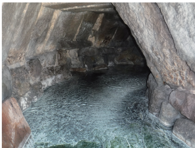
写真 14 芦之湯第 4 号源泉（黄金湯）の横穴内部。奥から温泉が流れてきます。穴が崩れないように石組みで支えられています。
