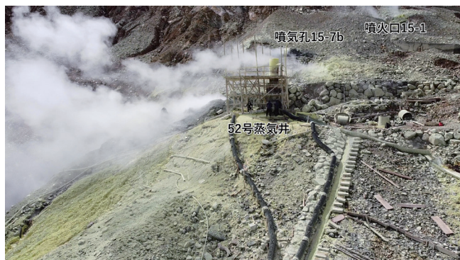
写真10 52 号蒸気井の斜面上側 ( 南側 ) には、噴気孔 15-7b と噴火口 15-1 から噴気が出ています。この他にも、52 号蒸気井の東側 ( 画面左側 ) では、いくつかの噴気孔が出現しています。
