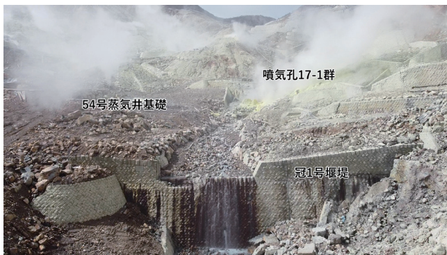
写真2 左側にある54号蒸気井は、2021年7月の大雨による土石流により、造成塔が倒壊し、撮影時は基礎部分から噴気が噴出しています。噴気孔 17-1 群付近には、噴出した硫黄で黄色くなっています。
