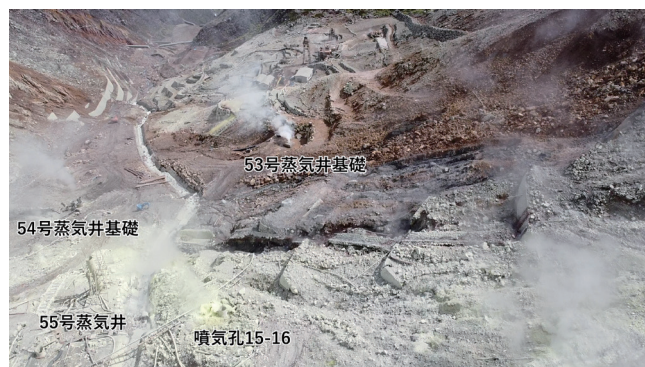
写真 18 53 号蒸気井の基礎部分から出ている噴気は、54 号蒸気井から出る噴気に比べると白色が強く見えます。これは噴気温度の差ではなく、噴気孔が石で塞がれており、その隙間から噴気が出ていることで、噴気の状態が大きく変化したためと考えられます。
