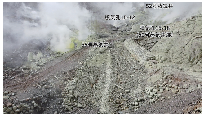
写真5 55号蒸気井は、休止中のため、造成塔の上部から噴気は出ていませんが、蒸気井下部の堰堤からは、自然噴気が出ていて、堰堤が硫黄で黄色くなっています。
