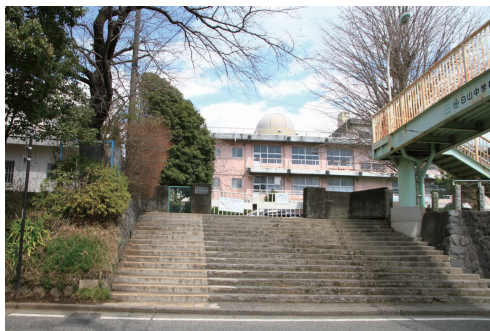
写真 1 敷地の下を通る道路から見た校舎。屋根の上にはプラネタリウムが見えます。震災追憶碑はこの階段を上がって左手にあります。
