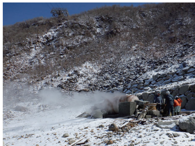
写真 13 大涌谷温泉の横置き（タンク型）の温泉造成装置。湯気が出ているタンク内の水に蒸気を吹きかけて温泉が造成され、配管をとおして運ばれていきます。
