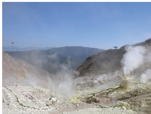
写真 11 大涌谷温泉の蒸気造成エリア。ロープウェイの通っている谷で、深さ数百mの蒸気井が数多く掘られて利用されています。
