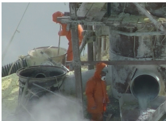
写真6 大涌谷温泉での蒸気井メンテナンスの風景。有毒な火山ガスを防ぐために、ガスマスクをつけて作業をしています。周辺は大量の硫黄で黄色くなっています。
