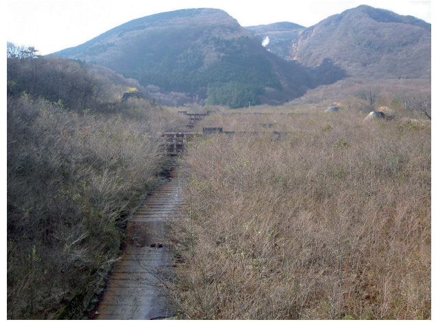
写真 15 早雲山から流下する須沢に設けられた砂防ダム。土石流が発生してもここで土砂をせき止めて下流側の温泉場に影響がでないように作られています。
