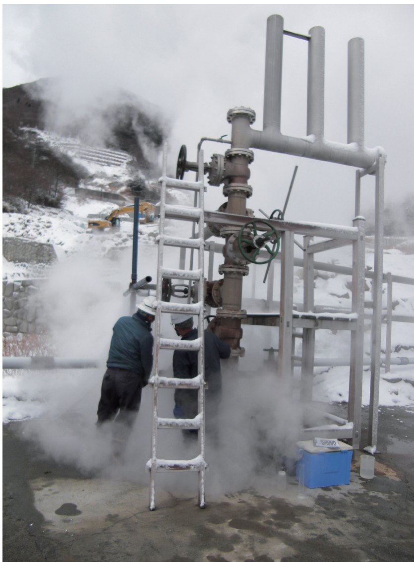
写真5 湯ノ花沢温泉での蒸気井メンテナンスの様子。雪の中での作業ですが、高温の蒸気の影響で足下の雪は溶けて乾いています。
