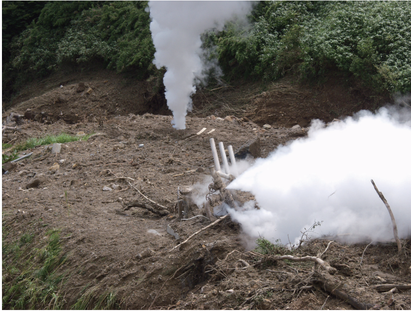
写真 19 土石流で破壊された湯ノ花沢温泉の蒸気井と温泉造成施設。破壊された蒸気井から火山ガスが噴出しています。(2005 年 8 月撮影)
