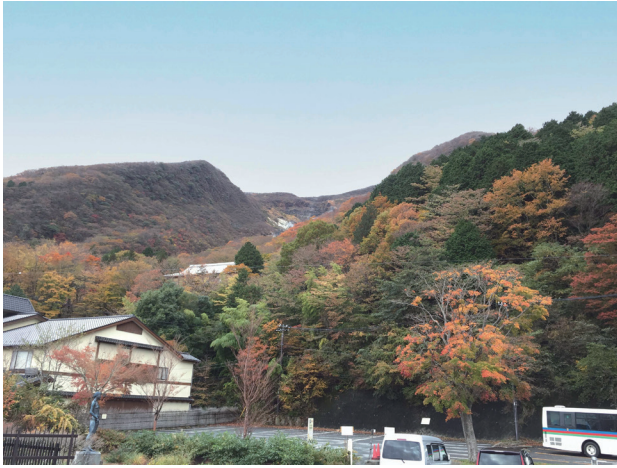
写真 14 早雲山駅付近からみた紅葉の早雲山遠景（2015 年 11 月撮影）。左側の建物（早雲閣）は 2019 年の土石流で壊されて現在はありません。
