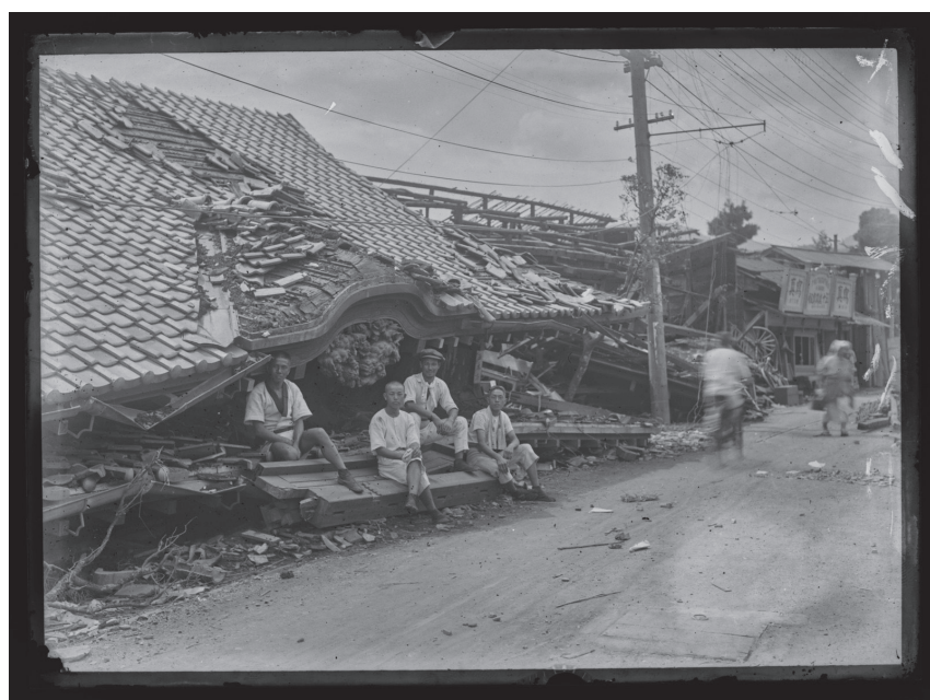
写真4 瓦の重みで崩れた濟世堂薬局小西本店（小田原市立中央図書館蔵）
