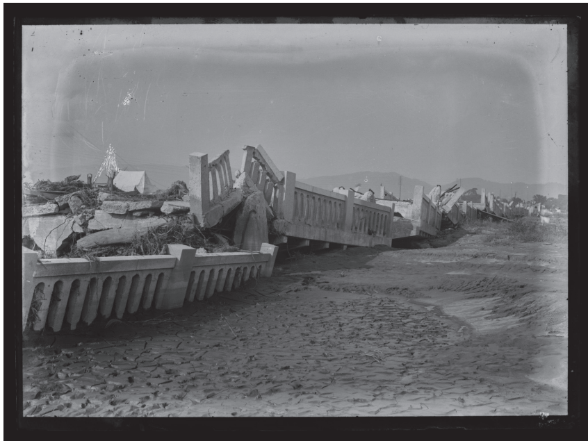
写真2 橋桁が落下した酒匂橋（小田原市立中央図書館蔵）
