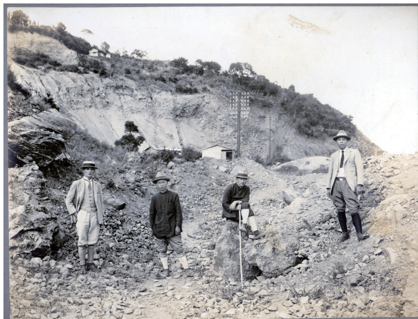
写真13 復旧工事関係者と根府川駅上方の地すべりの跡（個人蔵）
