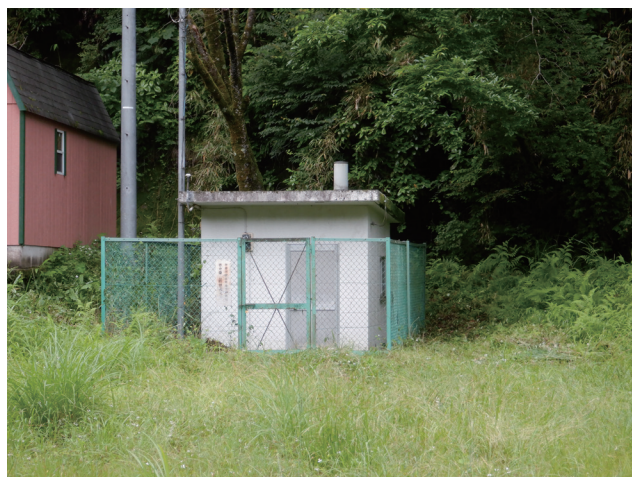
写真 1 寄観測点外観
