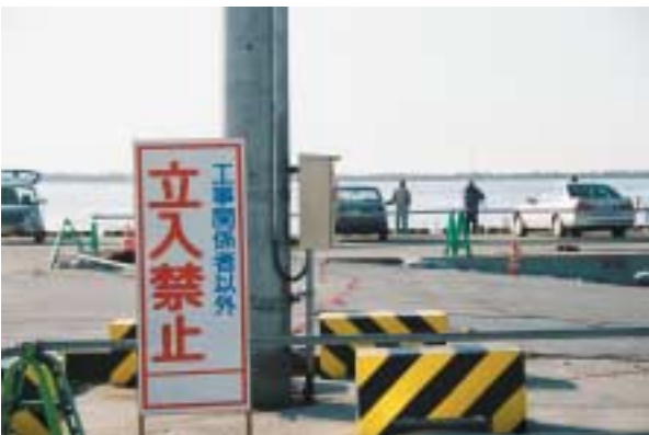
写真 6( 釧路港西港第四埠頭、釧路市) 埠頭には事故防止のため立入禁止の看板が立てられていたが、その先で釣り客も多数見受けられた。埠頭自体の復旧には、まだかなりの時間を要すると思われるが、住民の生活は落ち着きを取り戻しているようであった。
