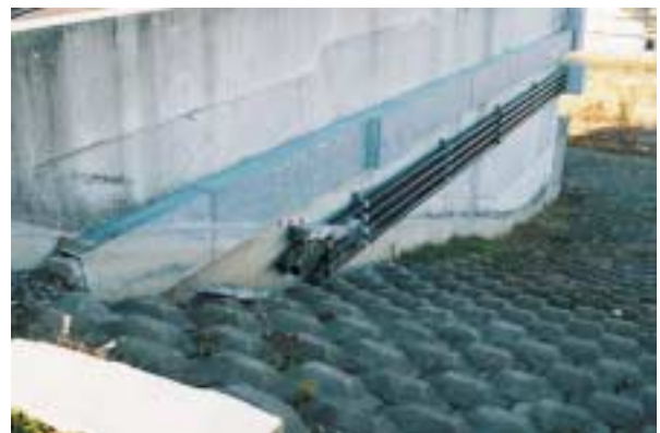
写真 7( 十勝河口橋、豊頃町) 十勝河口橋の豊頃側橋台に生じた抜け上がり。抜け上がり量は50cm程度であった。
