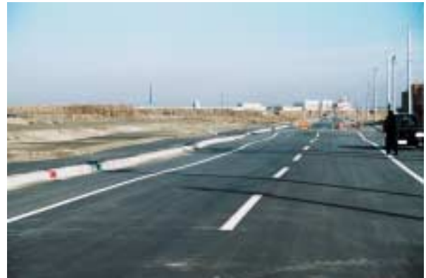
写真 5( 釧路港西港第四埠頭西側、南北方向に伸びる取付道路、釧路市) 第四埠頭の西側のほぼ南北方向に伸びる取付道路。白線の状況から、路面が波打っている。波打った路面の山と山の間隔は25～30m程度であった。
