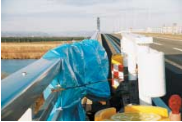
写真8(十勝河口橋、豊頃町) 橋の破損。舗装面は修復され歩道を示す白線は真直ぐにつながっているが、橋の欄干には食い違いが残っている(写真の左手が北側)。ズレの量は最大で70cm程度であった。
