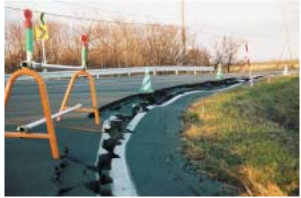
写真9(大津港、豊頃町) 港の取付道路では、液状化による路側帯の落ち込み、路面の亀裂などがいたるところで起きていた。
