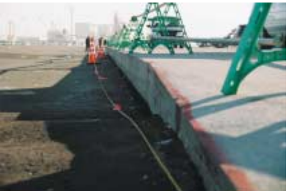
写真3(釧路港西港第四埠頭、釧路市)
